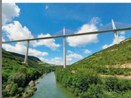
Le Viaduc de Millau (photo ci-contre), dans l'Aveyron, est le pont à haubans le plus haut du monde (270 m). Un **pont à haubans** est une variété de **pont suspendu** où le tablier est soutenu de manière équilibrée par des câbles appelés haubans.
